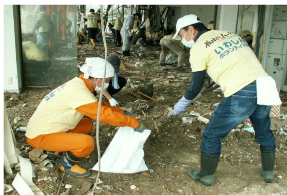
【津波被災地での瓦礫除去ボランティア活動】
