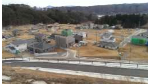
住宅の建設が進む宮古市田老地区三王団地 (平成28年3月)
