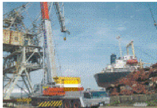
< A B L 実績の事例 > 大型クレーン
