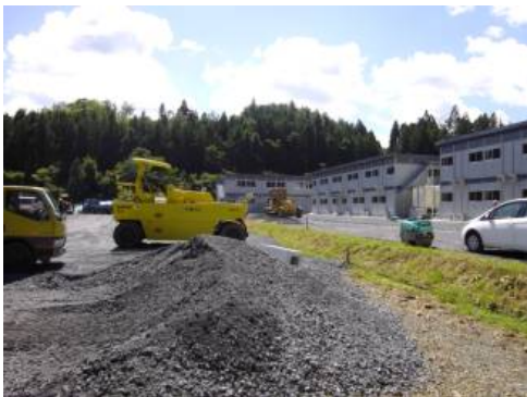
寄宿舎建設中の様子
