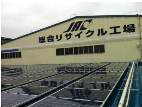
【図表 26】 太陽光発電設備
