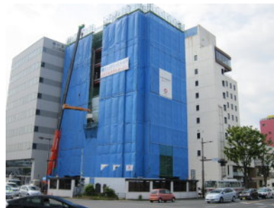
《いわき市ホテル建設現場》
