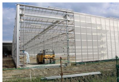
《栽培施設の建設現場》
