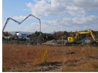
《新工場建設現場》
