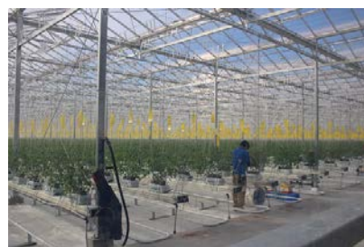
《完成した栽培施設》
