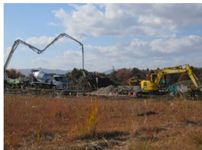
《新工場建設現場》
