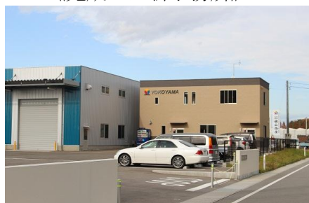
《完成した新事務所》
