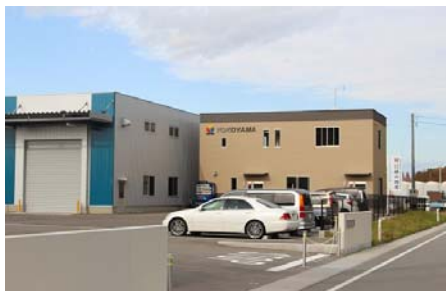
《完成した新事務所》
