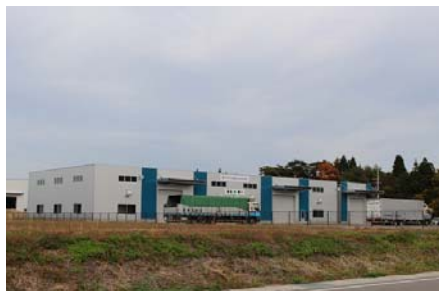
《新倉庫の全景》
