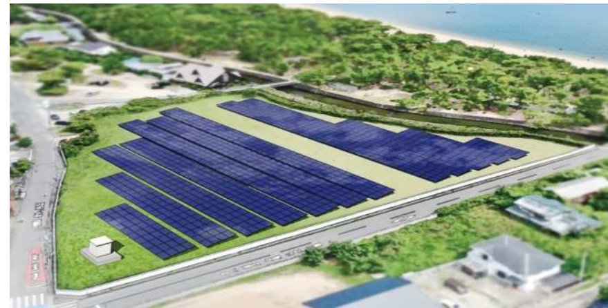
太陽光発電設備の設置
