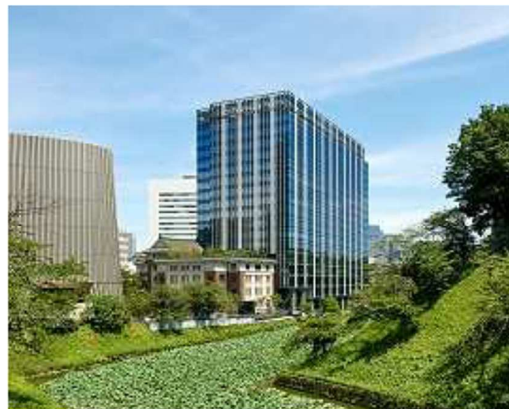
「九段会館テラス」外観 (田安門より)
