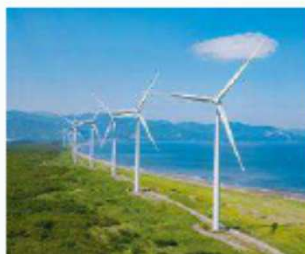
リネネ鉄函風力発電所
