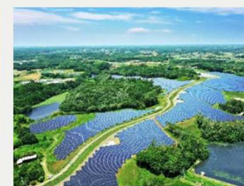
リエネ行方太陽光発電所 (茨城県) 定格容量 : 28MW (2021年3月期運転開始)
