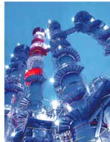
プロピレンオキサイド製造プラント
