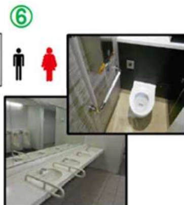
⑥ 一般用各トイレの1便房1洗面に手すり設置
