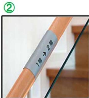
② 階段手摺に行先階点字ラベル
