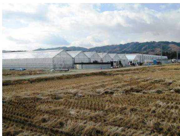
完成した最新設備の大型ハウス
