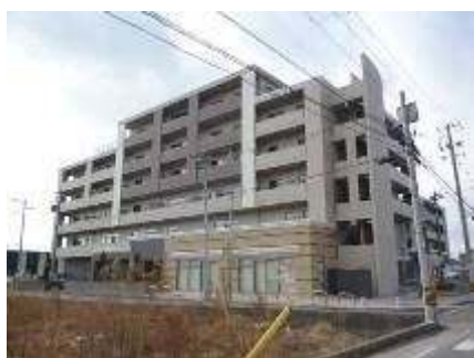
平成25年2月竣工の福祉施設
