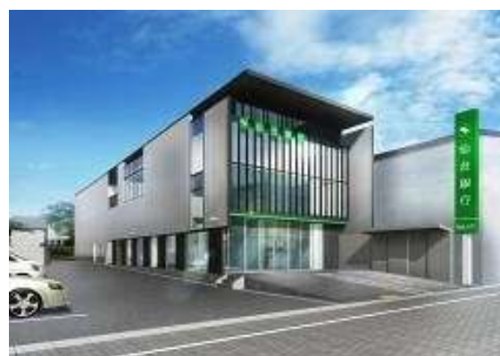
新・塩釜支店（平成 25 年 7 月）
