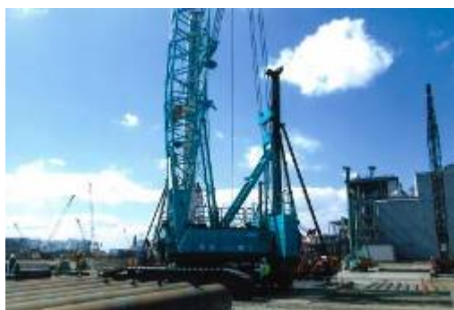
<ABL実績の事例> クローラクレーン
