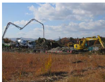
《C 社新工場建設現場》
