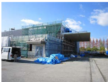
《B 社新工場建設現場》
