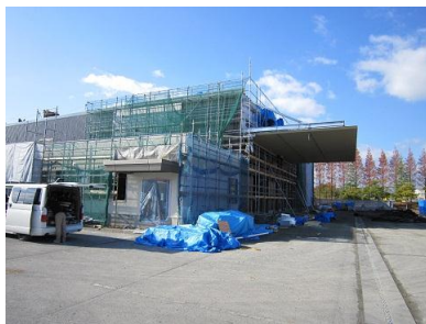
《D社新工場建設現場》
