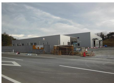
《新工場建設現場》
