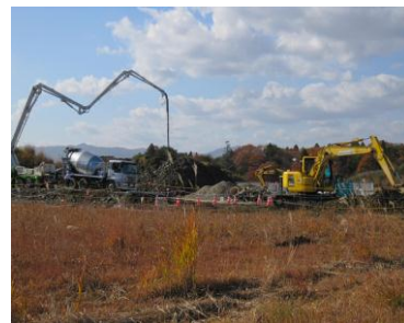
《E社新工場建設現場》
