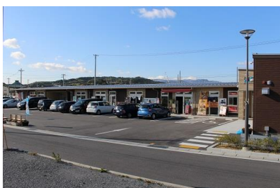
《商業施設の全景》
