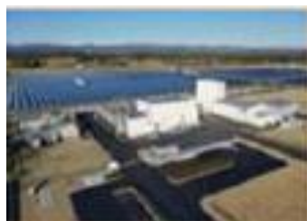
福島水素エネルギー研究フィールド(2020年開所)
