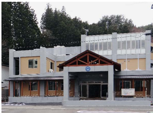
田老総合事務所庁舎
