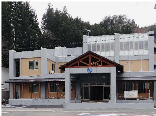
田老総合事務所庁舎
